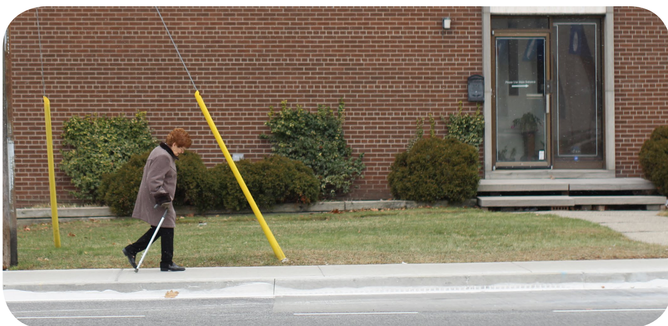
Figure 9. Certains obstacles sont cachés à la vue de tous. Des escaliers sans balustrade rendent une entrée inaccessible.
