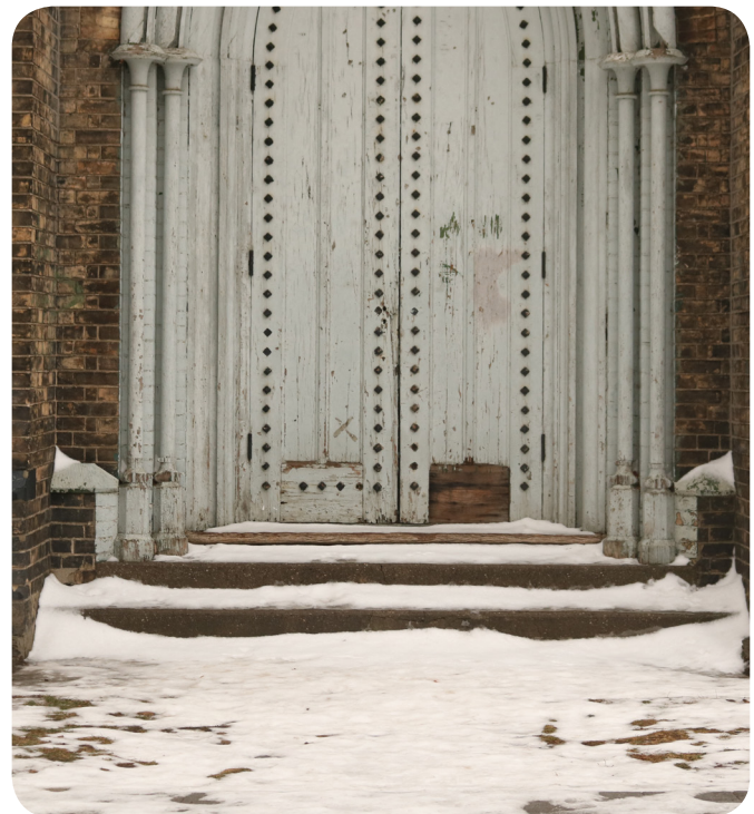
Figura 2. Los escalones pueden ser una barrera y si están cubiertos de nieve lo hacen peor.
