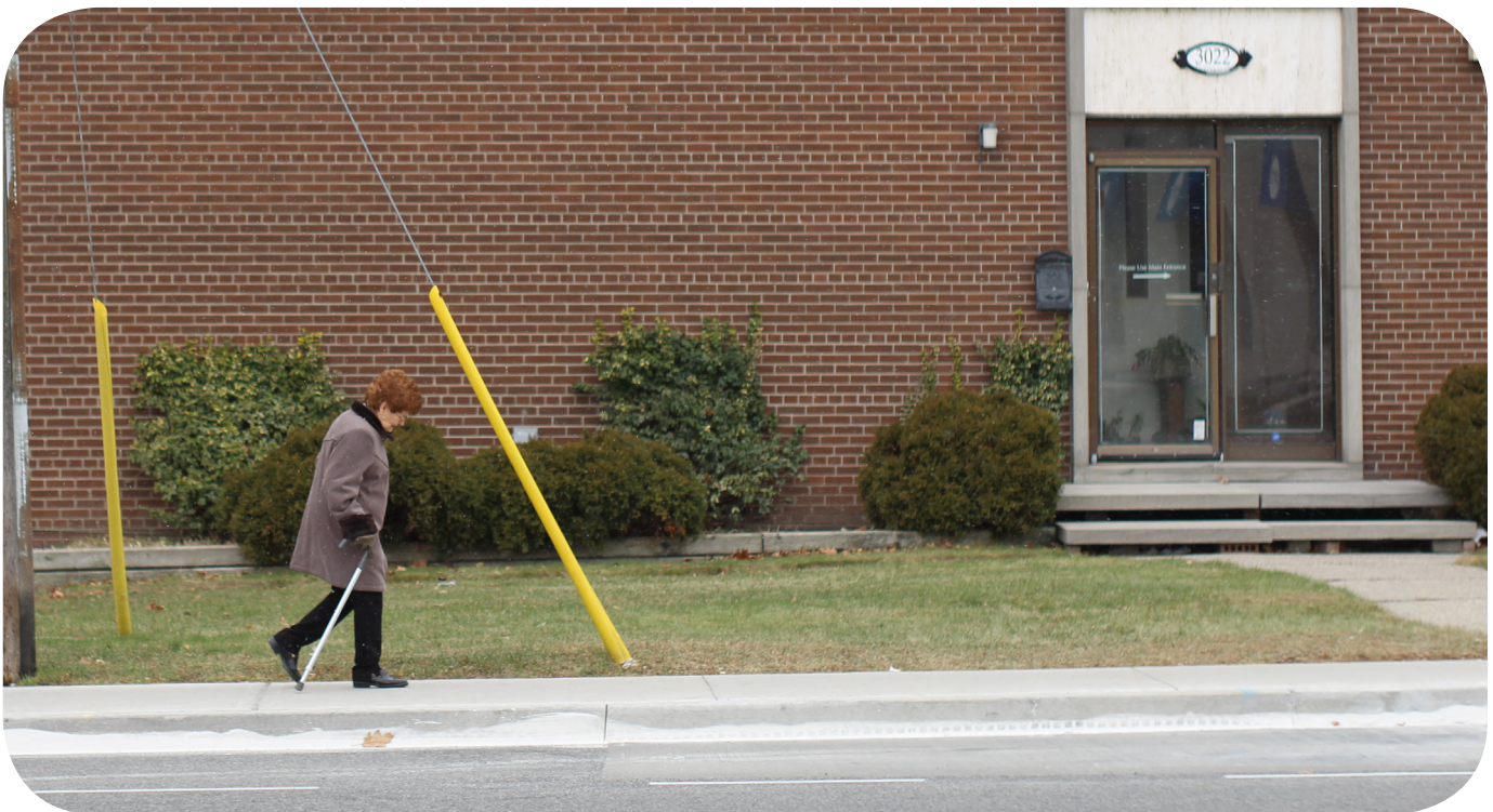
Figura 9. Algunas barreras están ocultas a la vista. Las escaleras sin barandillas hacen que la entrada sea inaccesible.
